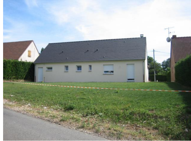
Couverture en tuiles plates foncées
