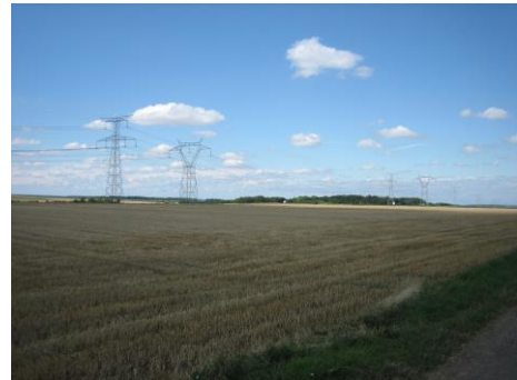
Lignes Haute Tension
