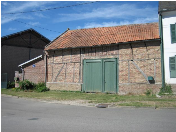
Ossature bois et remplissage en terre cuite
