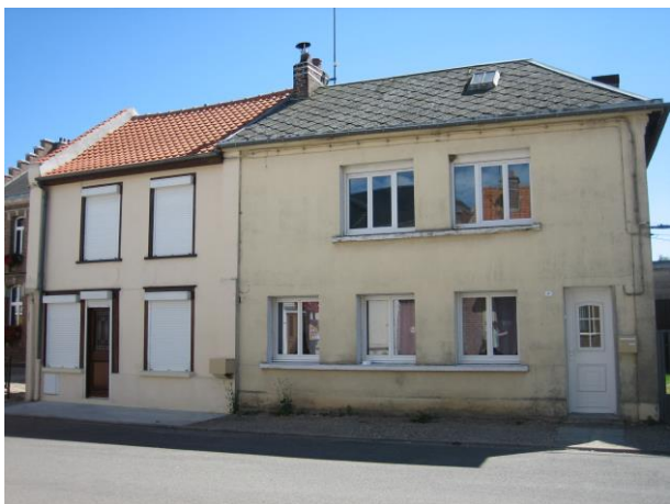
Couverture en fibrociment
