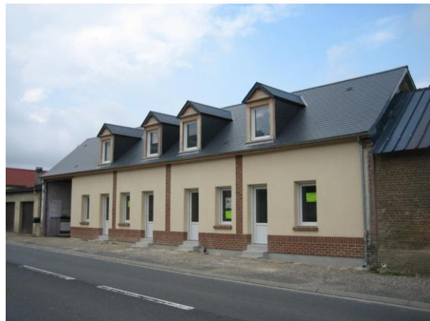
Réhabilitation du bâti ancien en front à rue – RD 1001 (2011)
