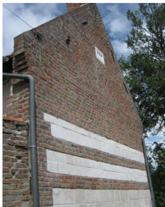
Pignon en brique et maçonnerie en couteaux en partie sommital du pignon
