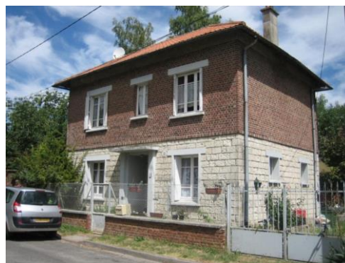
Matériaux différents par niveau d'élévation (brique / béton / pierre agglomérée)
