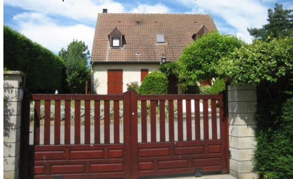
Implantation en retrait de l'alignement, rue Neuve
