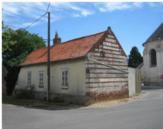
Maison du XVIIIème siècle avec appareillage « rouge barre » et maçonnerie en couteaux / Couverture de tuiles pannes
