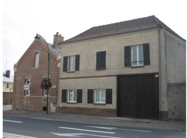
Grands volumes, route Nationale (RD 1001)
