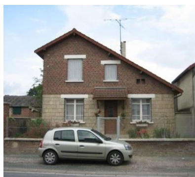
Matériaux différents par niveau d'élévation (brique / béton / pierre agglomérée)
