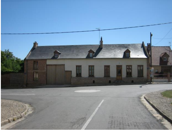
Couverture en ardoises
