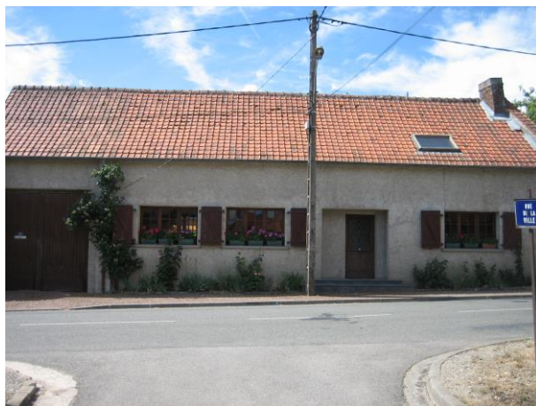
Couverture en tuiles mécaniques orange
